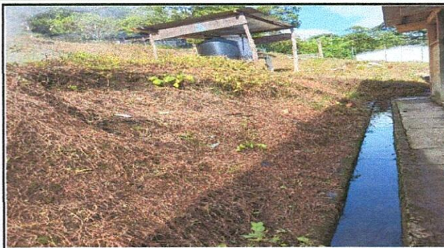
Foto 2: MEJORAMIENTO DE CUNETA
