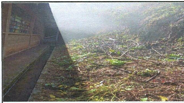
Foto 4: AREA PARA MEJORAMIENTO DE MURO DE CONTENCIÓN CON DRENAJE FRANCES
